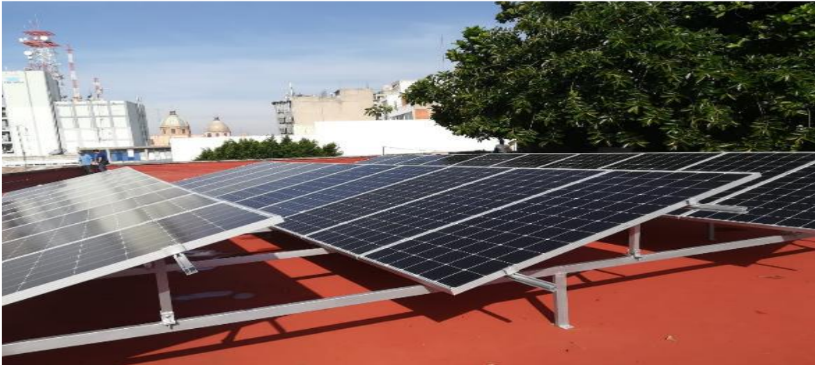
Instalación de celdas solares en edificios de la administración pública municipal Fotografía: Dirección General de Medio Ambiente del Municipio de León.
